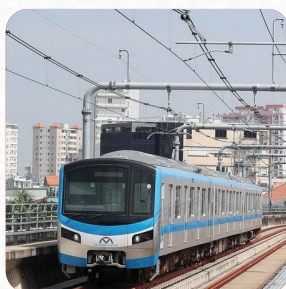
Dự án Metro Bến Thành - Suối Tiên
